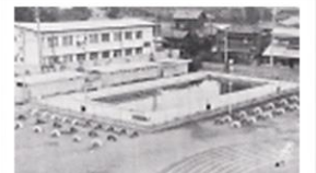
プール完成・タイヤ設置
