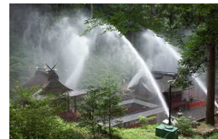
≪消火施設(放水銃)の設置≫
