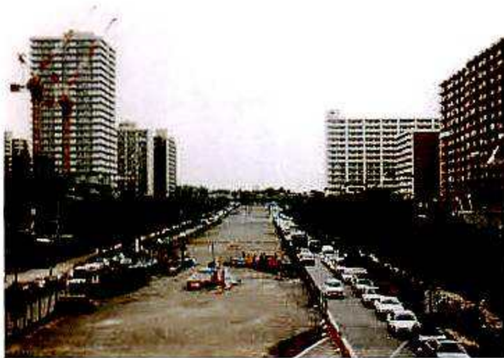
▲ 月見大橋から見た工事中の大通り
