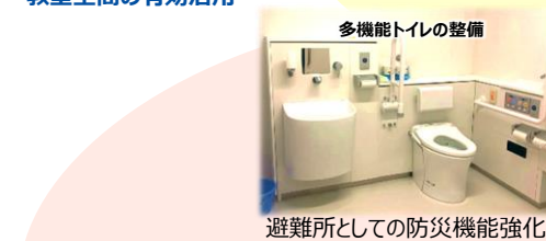
多機能トイレの整備 避難所としての防災機能強化
