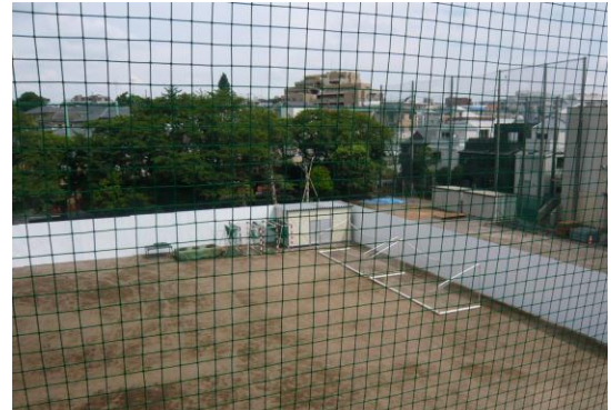
校庭南側外構工事始まる
