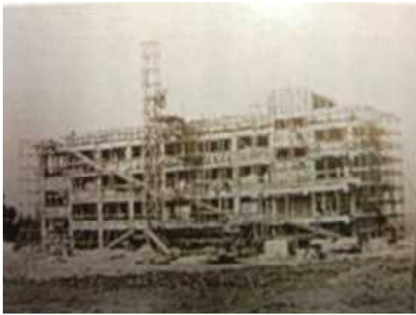
1959年（昭和34年）建築中の校舎 現在の校舎 第一期工事です。
