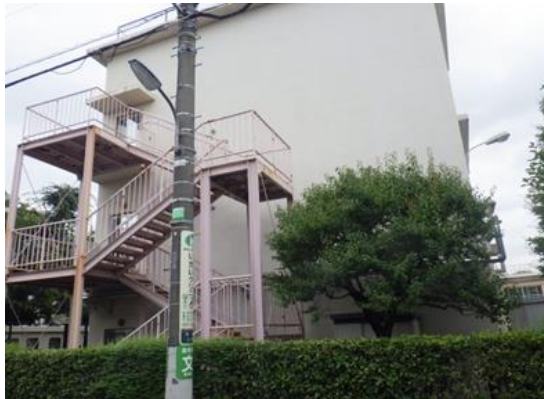
・西面外壁(1階～3階)
