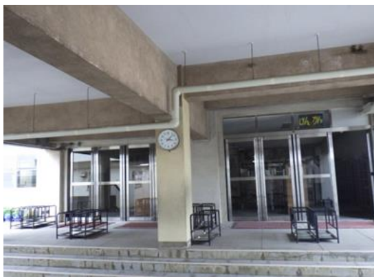
・連絡通路天井
