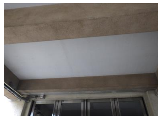
・連絡通路柱・梁
