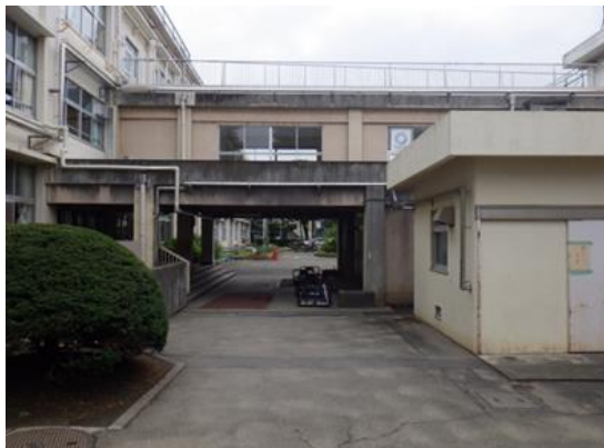
・連絡通路西壁
