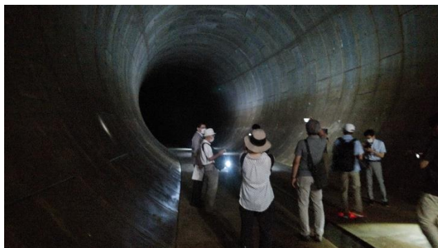
地下トンネル見学時の写真
