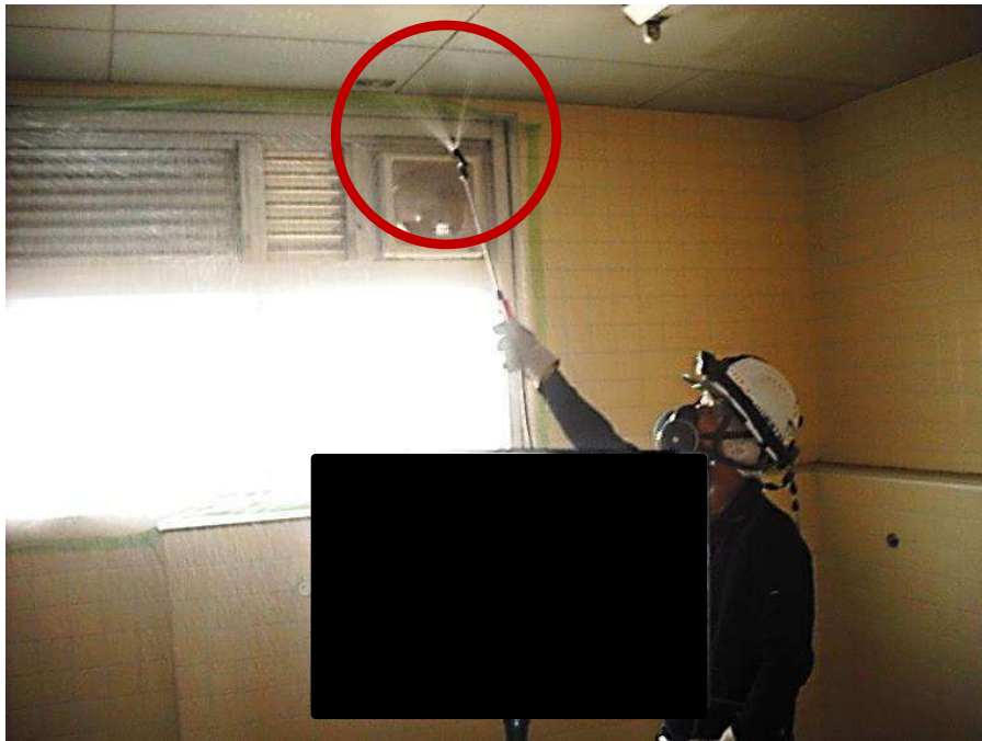
天井材に湿潤材 を散布
