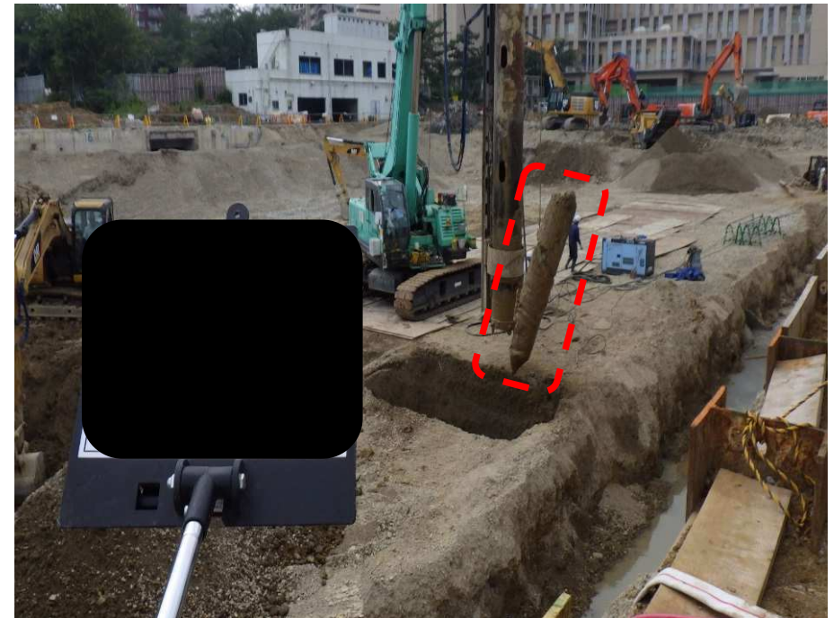
既存杭引抜き中
