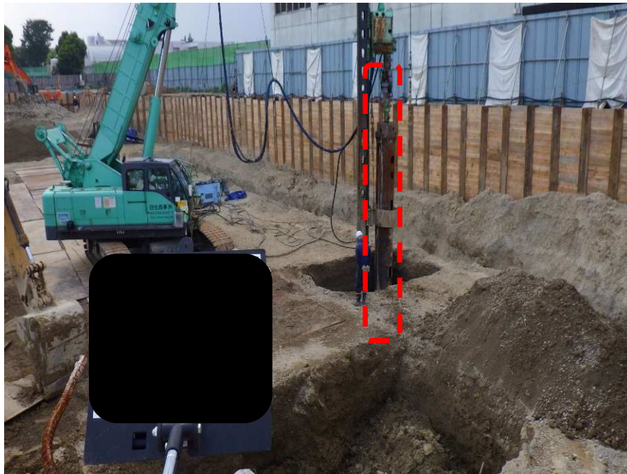
ケーシング削孔中
