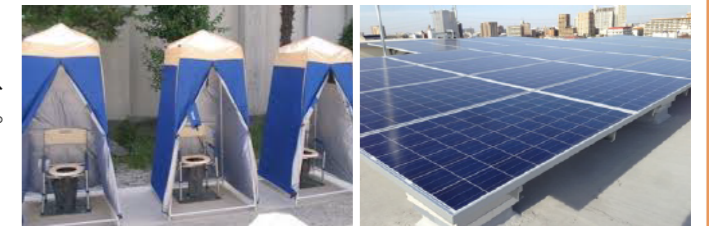
【マンホールトイレの設置】
