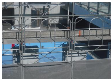
建築中のプールです
