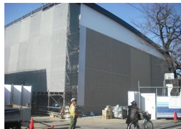
東側足場が外れました
