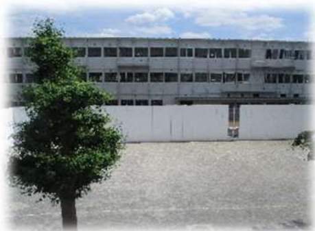
【建設中の仮校舎】
