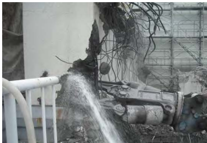
↑ 参考写真（圧砕工法）
