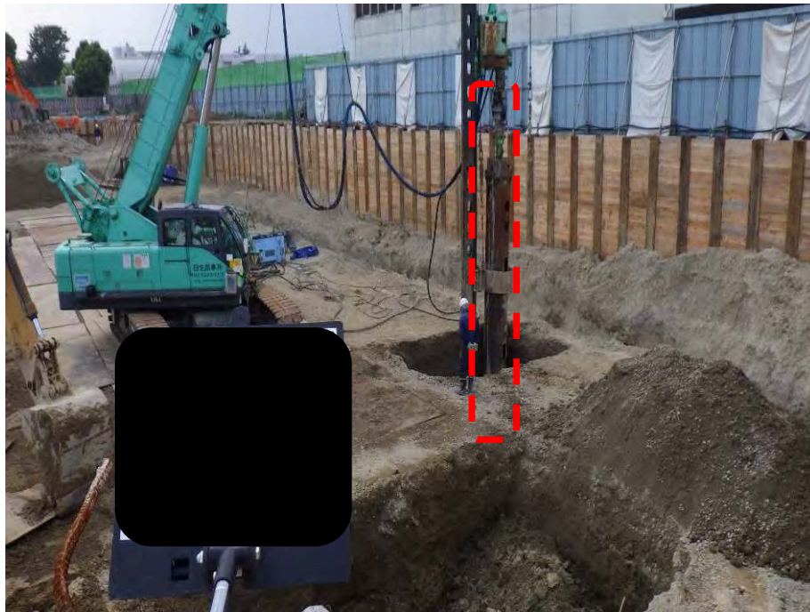
ケーシング削孔中
