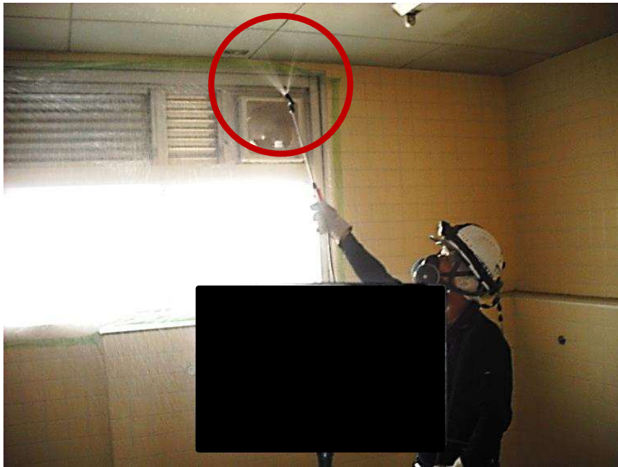
天井材に湿潤材 を散布
