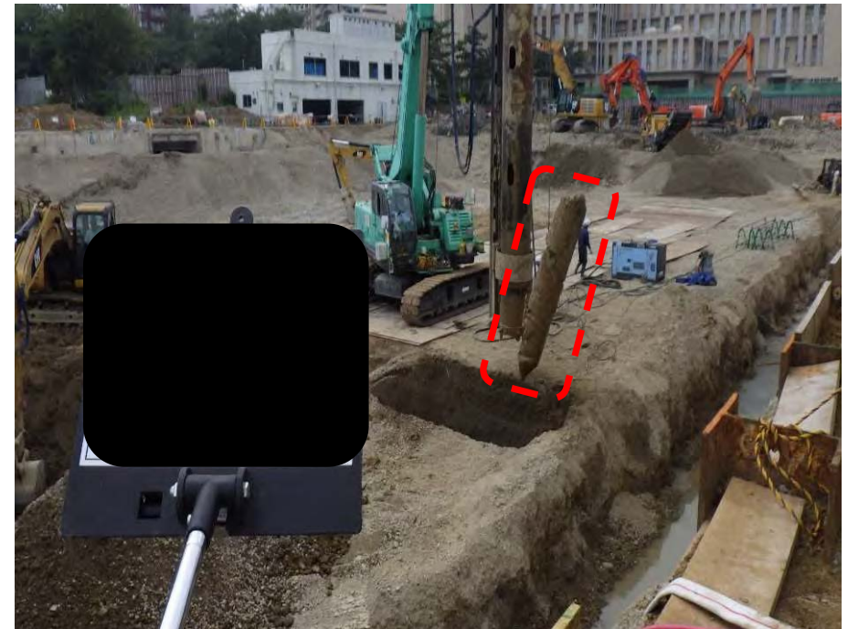
既存杭引抜き中
