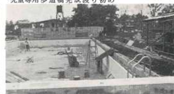
プール工事中
