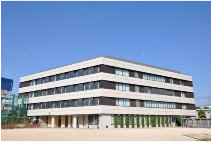
5角形のつくりで4階建て、新しくきれいな校舎です。
