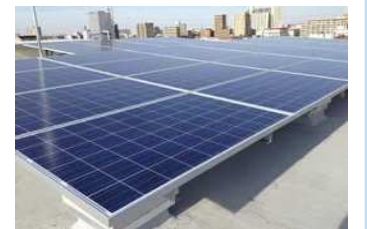
【太陽光パネルの設置】
