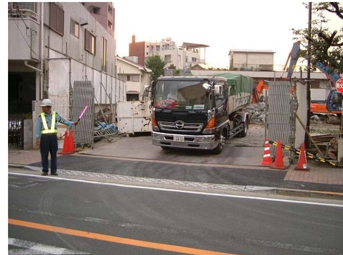
洗浄後誘導員により退場
