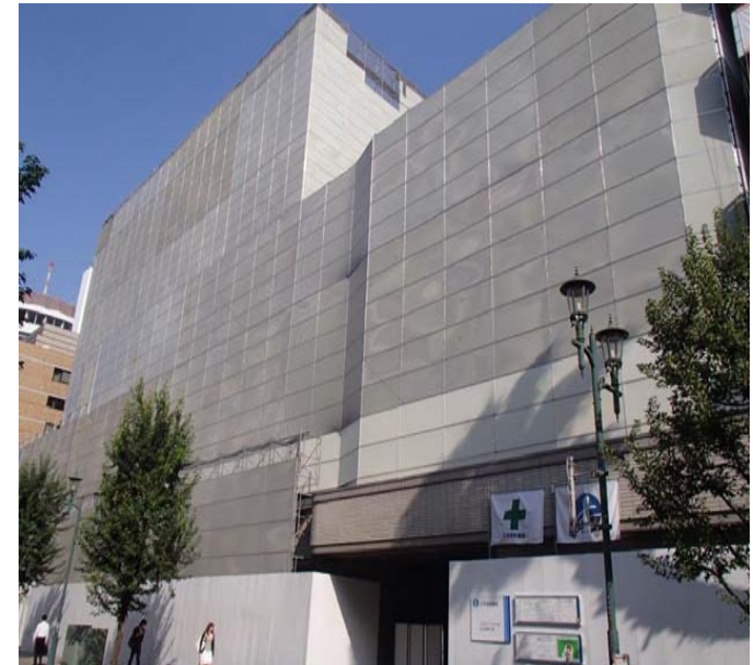
(例) 防音パネル養生
