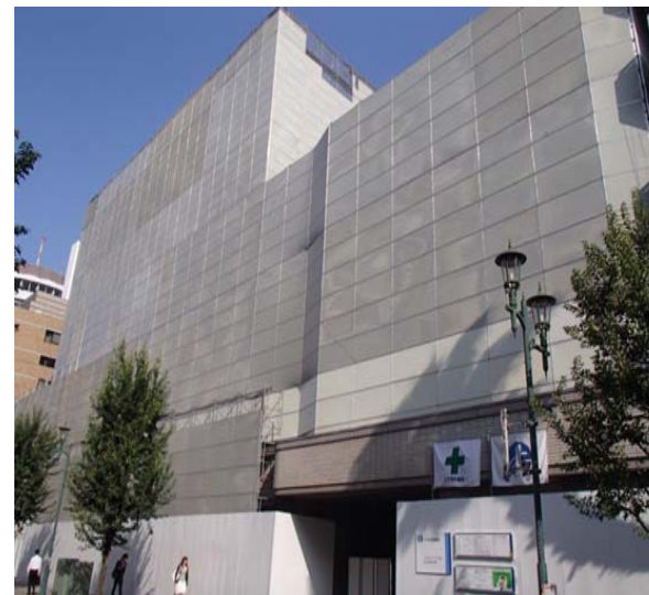
(例) 防音パネル養生
