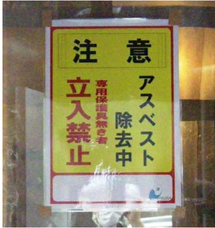
立入禁止措置
