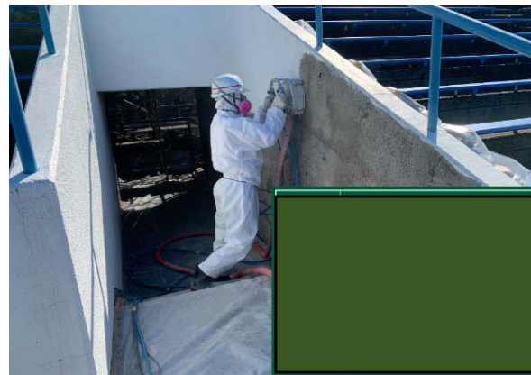
超高压水洗除去
