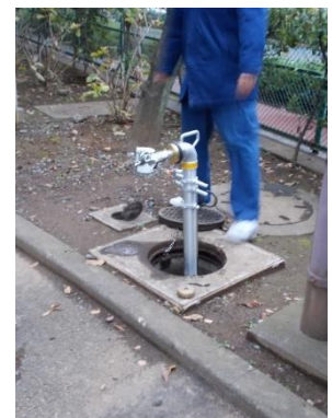
水道本管に直結した給水器
