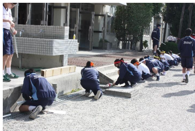
放送配線の設置
