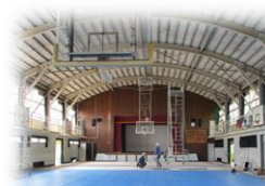
工事中と工事後です
